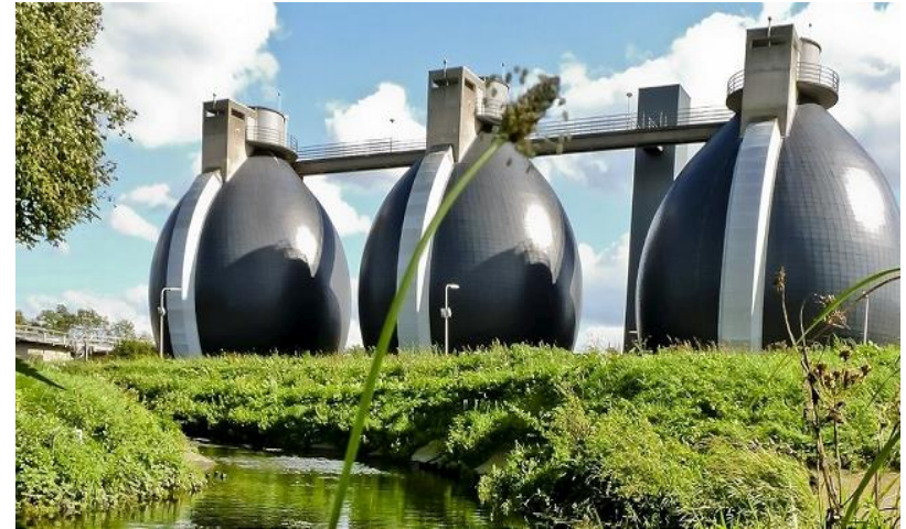
Slibgistingstanks met gashouder (RWZI Hengelo), Bron: https://www.vechtstromen.nl
