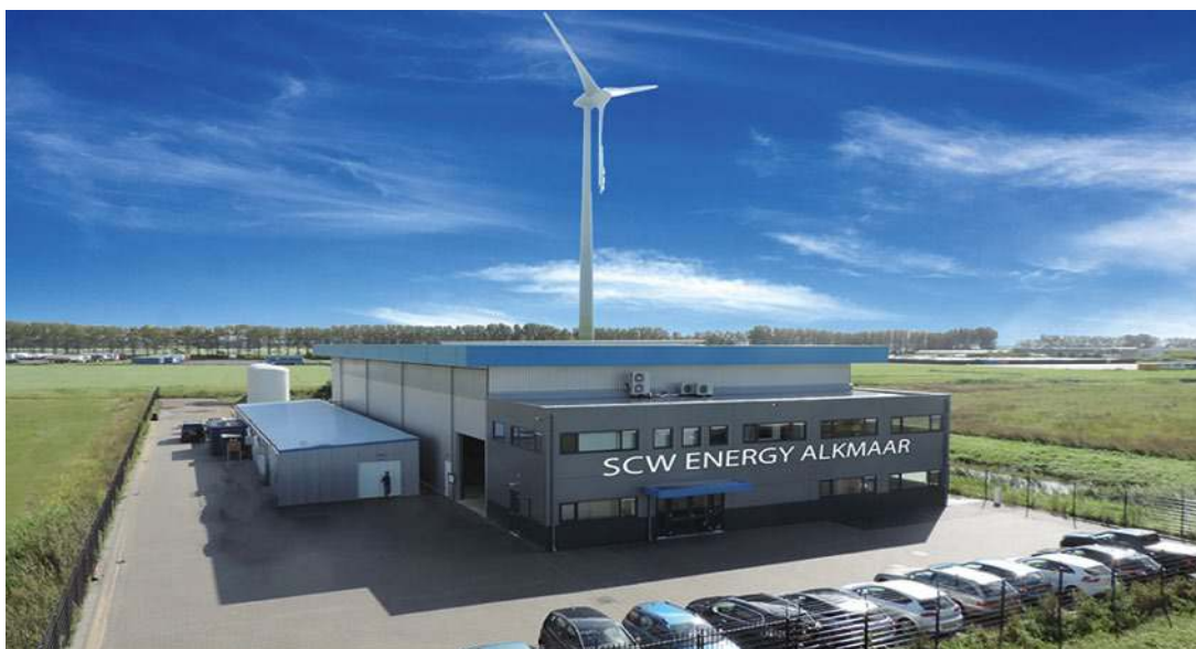
20 MW demo-installatie superkritische watervergassing, binnenkort op locatie uit te breiden naar 100 MW.
